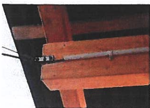
Bonne installation d'une ligne d'alimentation. Le câble à haute tension est placé dans un tube de plastique gris ininflammable. Pour aller jusqu'à la clôture, un câble de soutien est tendu.
